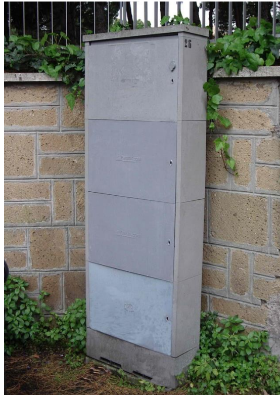
Armadio ripartilinee modulare in VTR da 1200 cp.
