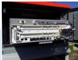
Sopralzo 48 porte VDSL2 installato su colonnina affiancata ad armadio
