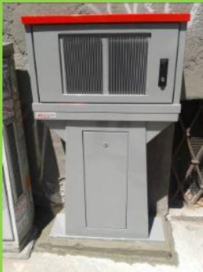
Sopralzo 48 porte VDSL2 installato su colonnina affiancata ad armadio
